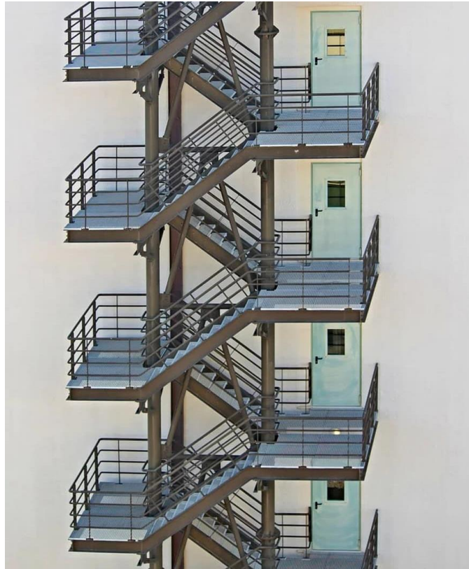
બહારનો દાદરો (External Staircase)
