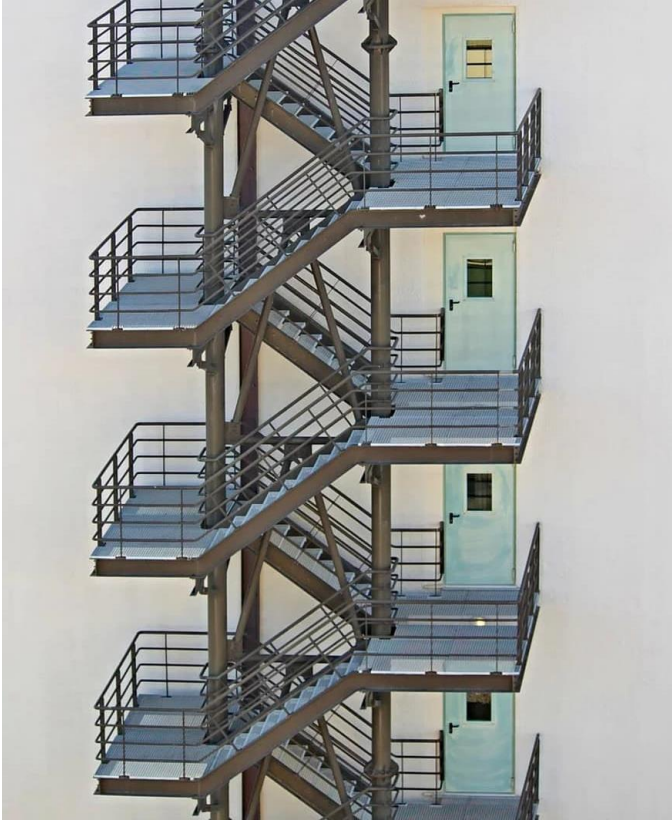
આકૃતિ ૧૪: બહારનો દાદરો (External Staircase)
