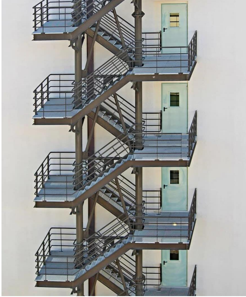
આકૃતિ ૧૪: બહારનો દાદરો (External Staircase)
