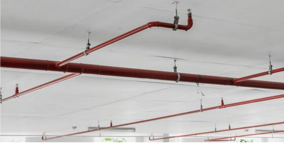
આકૃતિ ૨૫: ઓટોમેટિક સ્પ્રિંકલર સીસ્ટમ (Automatic Sprinkler System)
